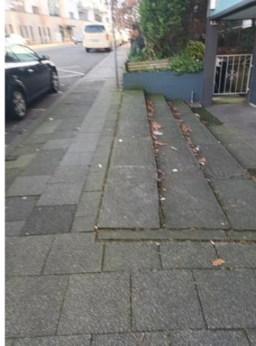
Schlecht erkennbare Stufen
