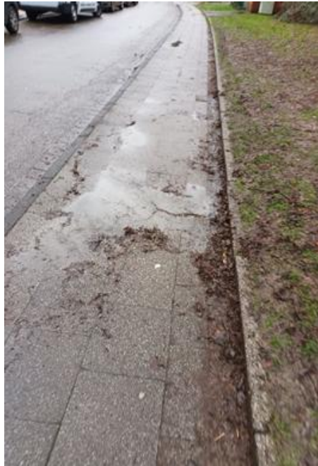
defekte Gehwegplatten
